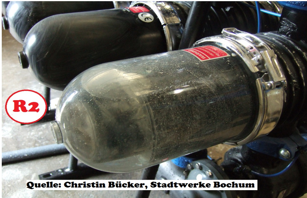
Abbildung 33: Durchsichtiges Filtermodul mit Wasser gefüllt
