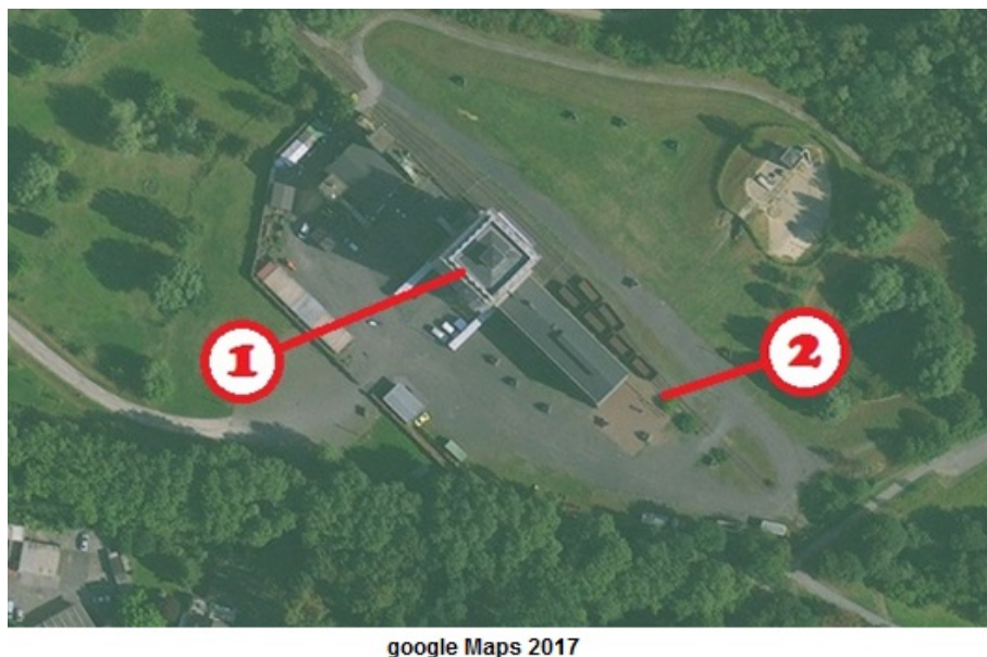
Abbildung 21: Übersicht zur Zeche Hannover, mit Maschinenhaus (1) und Außenanlage (2)
